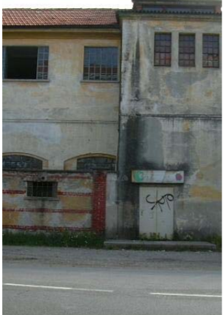
Sull'area dell'ex Torcitura verranno costruiti un supermercato, un centro residenziale, diversi uffici e un parcheggio interrato
