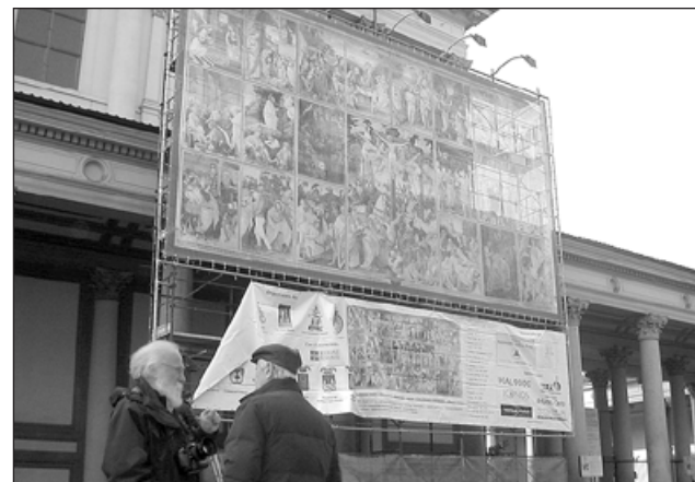
L'allestimento dell'impalcatura in piazza Duomo a Novara
